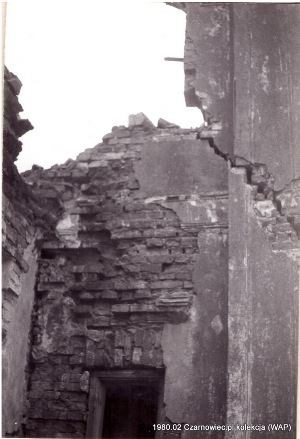
Pozostałości dworu, stan z 1980 r.
