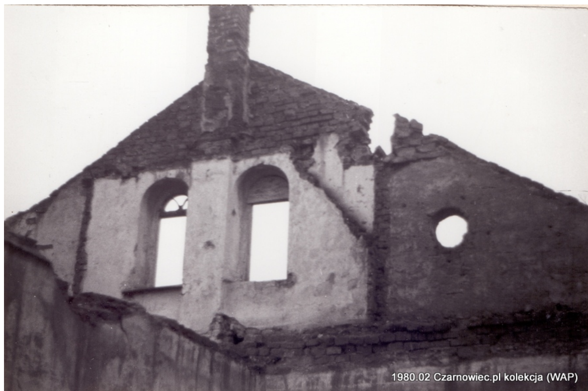
Ściana szczytowa, stan z 1980 r.
