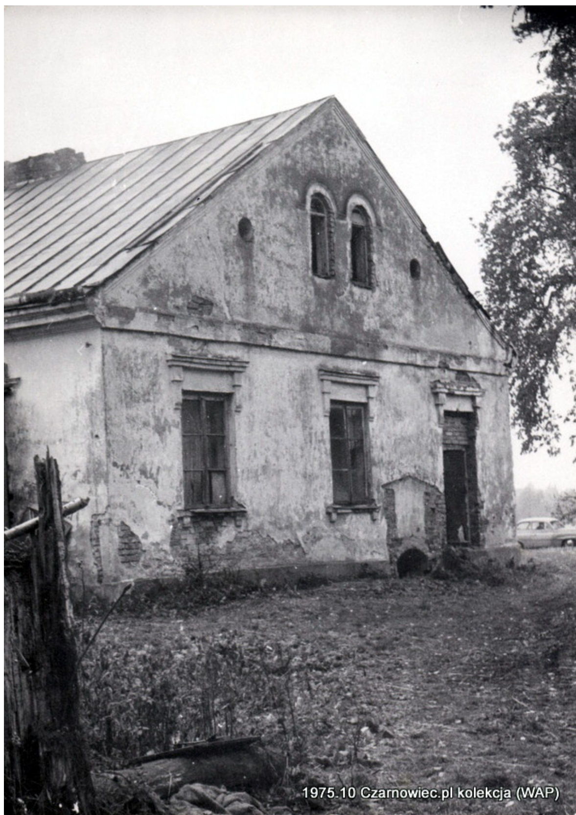
Ściana szczytowa dworu, stan z października 1975 .
