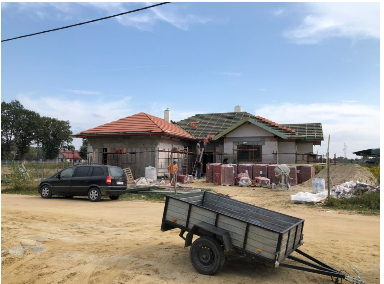
Budowa w 2019 r.
